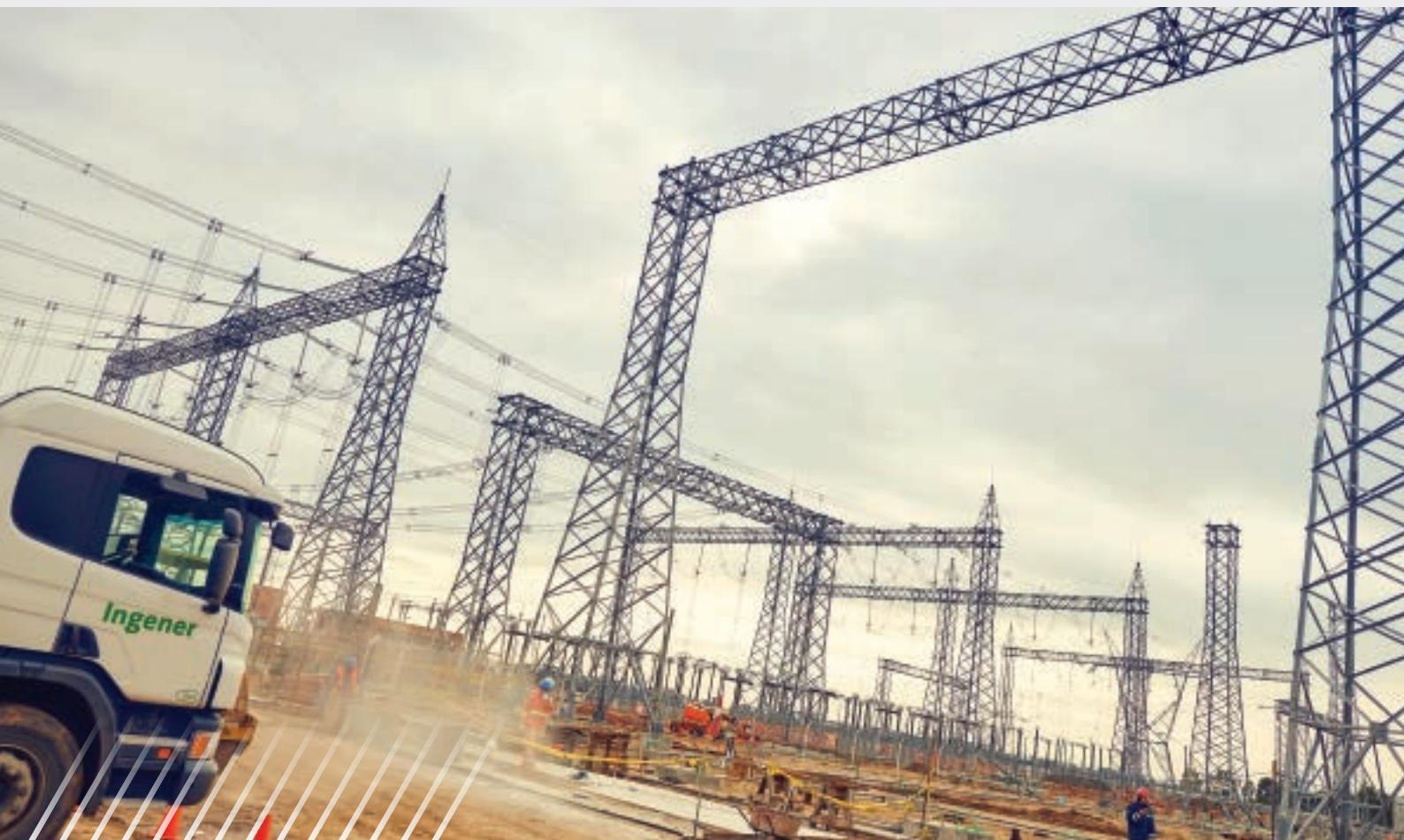
Entre 2015 y 2018 se construyó, en el Uruguay, la primera central térmica de Ciclo Combinado, compuesta por dos turbinas de gas y una turbina de vapor, totalizando una potencia instalada de 530 MW. Entre otros trabajos, Ingener realizó, para la empresa Siemens, la construcción de la estación de 150 kV y la ampliación de la estación en 500 kV.
