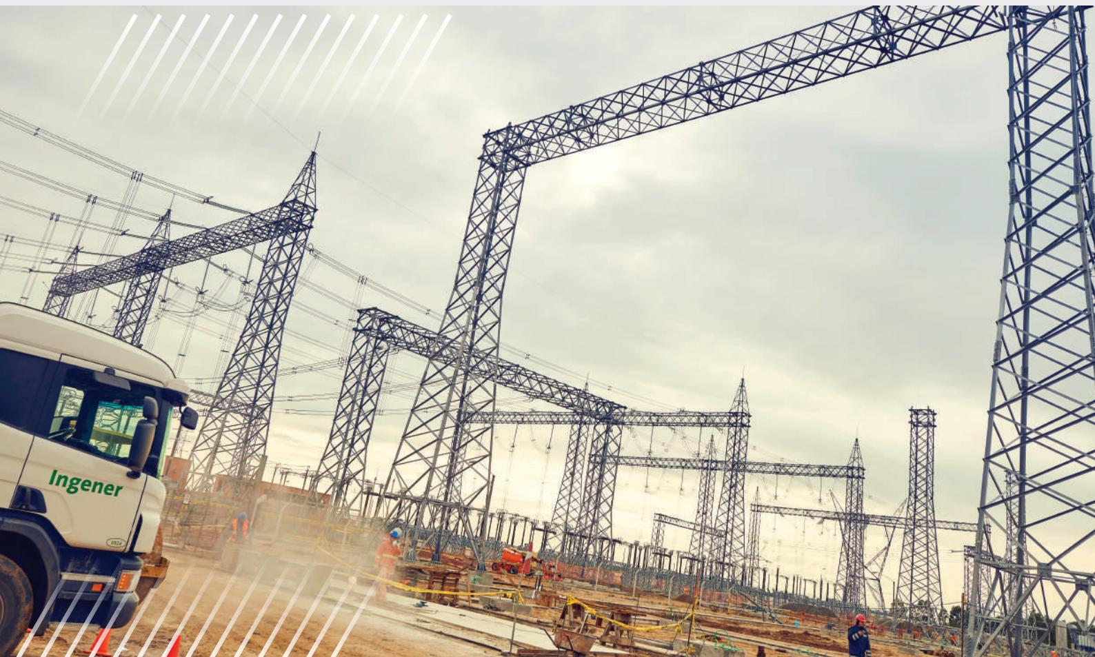
**Punta del Tigre:** Entre 2015 y 2018, se trabajó en la construcción de la estación de 150 kV y la ampliación de la estación en 500 kV de la primera central térmica de Ciclo Combinado en Punta del Tigre, departamento de San José.
